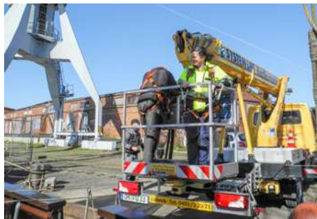
Steigkran und Hebebühne werden positioniert
