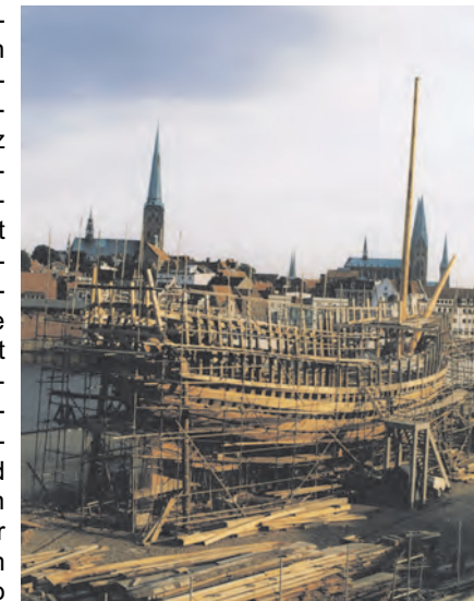
Blick auf den Bauplatz (2002)
