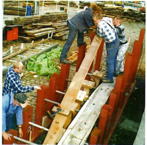
sprechend der Rumpfform gebogen. Nach dem auskühlen (über Nacht) haben sie die Krümmung beibehalten und konnten am Schiff montiert werden. Mit Schraubzwin-
