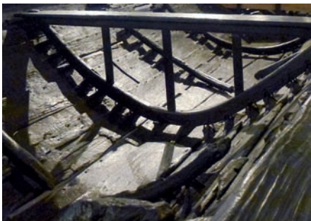
Der Blick in das Boot zeigt die Rahmenkonstruktion, bestehend aus der Bepunktung mit den Befestigungsklammern der Spanten, den Duchten und Abstützen der Duchten.
