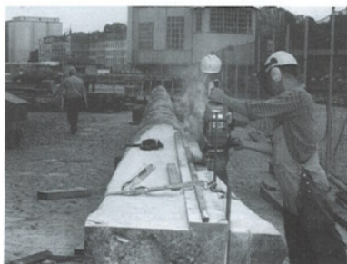
Aus der ehemals 40 m langen Douglasie wird der Großmast gefertigt
