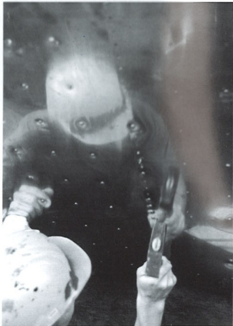
Die Kupferplatten werden angenagelt
